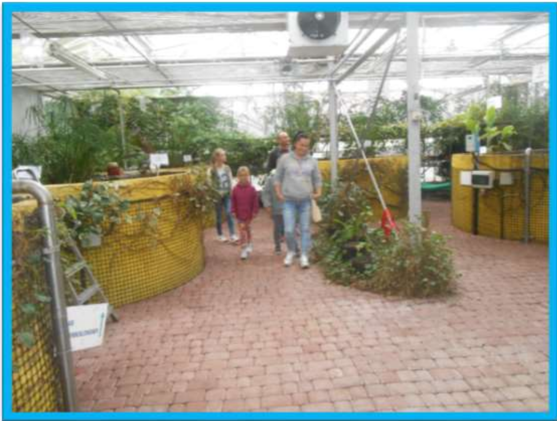
Fot.3. Oczyszczalnia Ścieków „Ogrody Odnowy”
