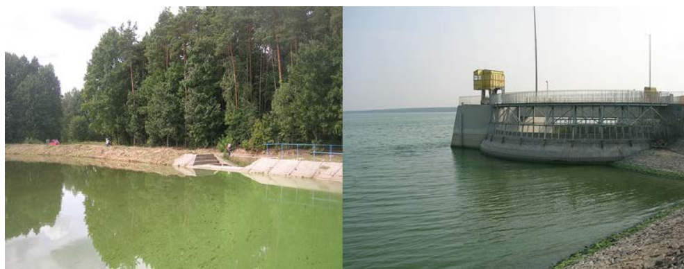
Rys. 6. Eutrofizacja zbiornika Psurów na rzece Prośnie (po lewej) oraz zbiornika Turawa na rzece Mała Panew (po prawej) (Fot. M. Wiatkowski)
