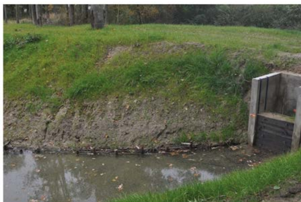
Rys. 5. Zastawka piętrząca wodę i przepust na zbiorniku retencyjnym w wydzielaniu 184g (Zbiornik III)
