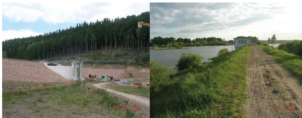
Rys. 8. Zbiornik wstępny Klingenberg na rzece Wilde Weißeritz (Niemcy) oraz zbiornik wstępny Jedlice w cofce zbiornika Turawa na rzece Mała Panew (Fot. M. Wiatkowski)
