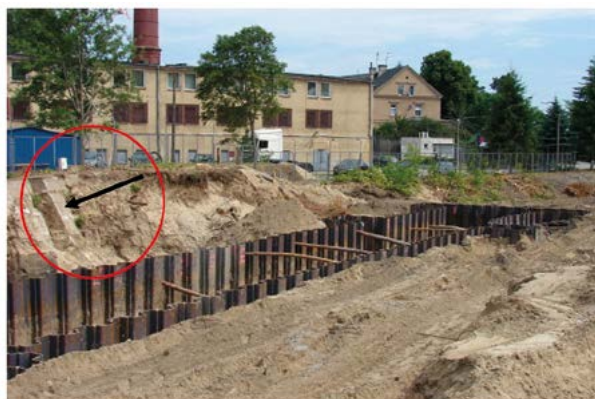
Ryc. 10. Fotografia z budowy (2010-10-26); na skarpie widoczny mur oporowy z przyporą wlotu do komory turbin ( http://www.czerwienski.pl/ )
