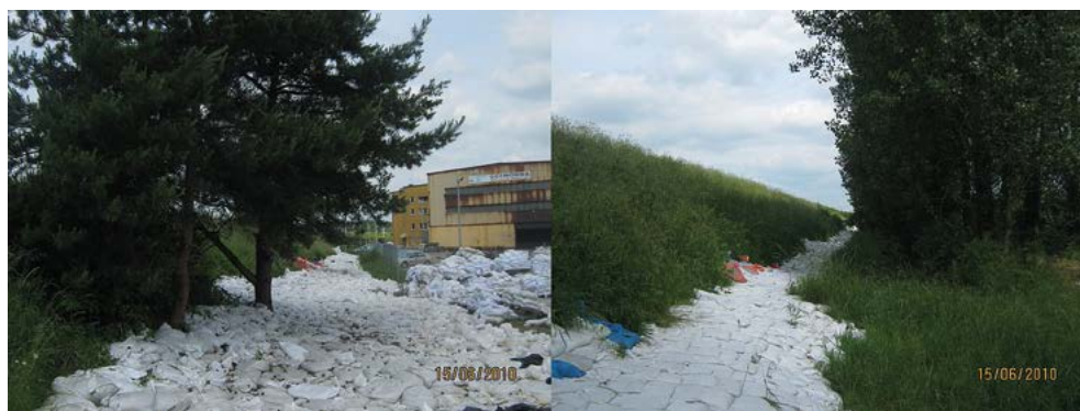
Rys. 2. Wały odrzańskie w przekroju Opole, w okresie powodzi na Odrze w 2010 r. Widok od strony zawala (Fot. M. Wiatkowski)
