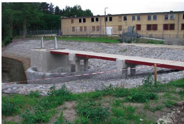
Rys. 7. Wieża przelewowa i umocnienie skarpy na lewym brzegu zbiornika (Fot. z okresu budowy) ( http://www.czerwiensk.pl/ )
