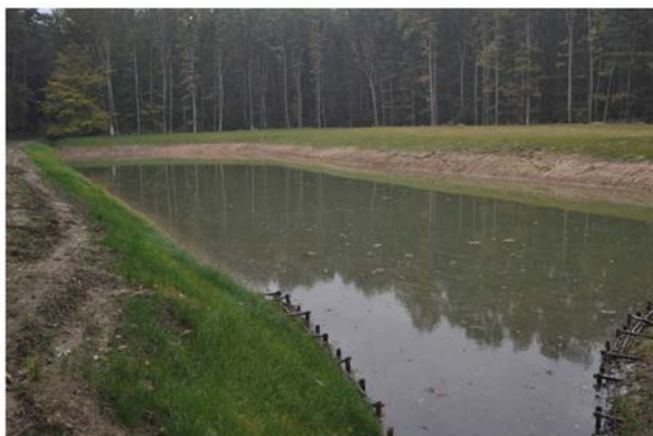
Rys. 4. Zbiornik retencyjny w wydzielaniu 184g (Zbiornik III)
