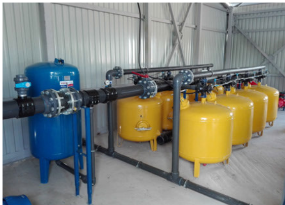
Fot. 32. Zestaw filtrów piaskowych. (W. Treder)
