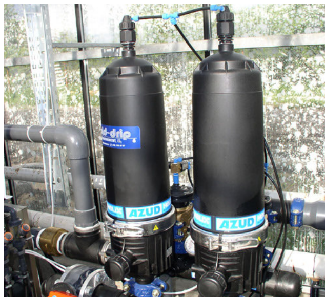
Fot. 31. Zestaw automatycznych filtrów dyskowych. (W. Treder)
