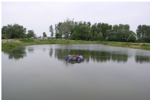
Fot. 12. Zbiornik retencyjny na cieku wodnym. (W. Tredner)
