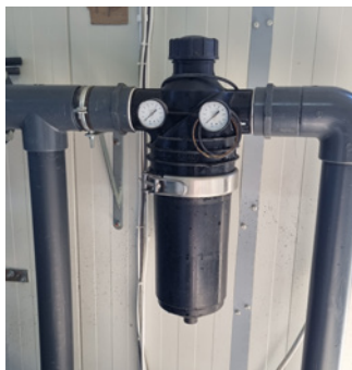
Fot. 26. Filtr wyposażony w manometry. (W. Treder)
