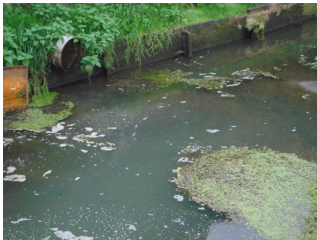
Fot. 18. Bujny rozwój glonów w zbiorniku retencyjnym. (W. Treder)
