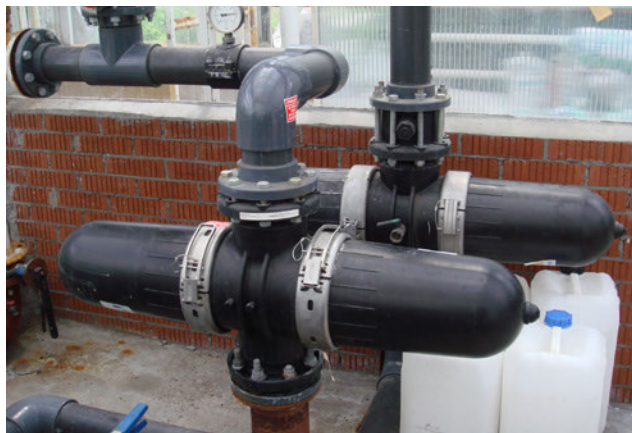
Fot. 30. Zestaw filtrów dyskowych. (W. Treder)
