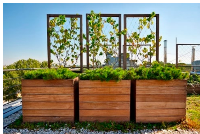
U góry zielony dach na budynku przy Alei Słowackiego w Krakowie, u dołu fragment zagospodarowania dachu biurowca Regent Office (fot. Herbewo).
