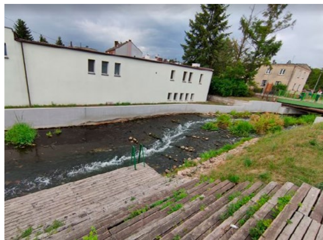
Przebudowany stopień wodny na rampę kamienną bystrotok. Rzeka Drawa w Złocieniu (fot. I. Biedroń).
