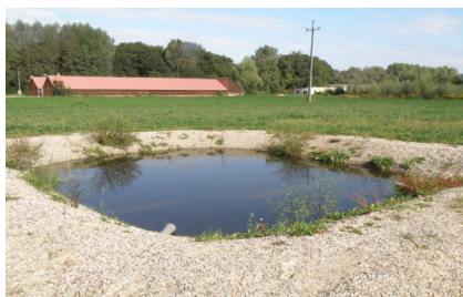
Sztuczne mokradło w ITP Falenty- osadnik [fot. P.Nawalany]
