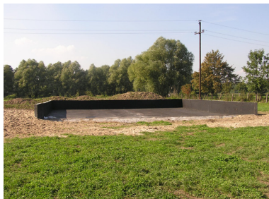
Nowa płyta obornikowa (fot. P.Nawalany)
