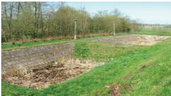
Rysunek 1. Dwie niecki stawów ściekowych wykonane przez wykopanie
