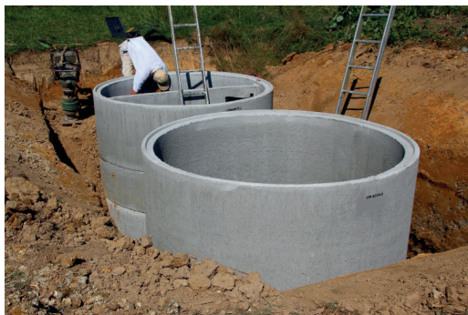
Rysunek 3. Szambo trzykomorowe dla jednego gospodarstwa domowego w trakcie realizacji
