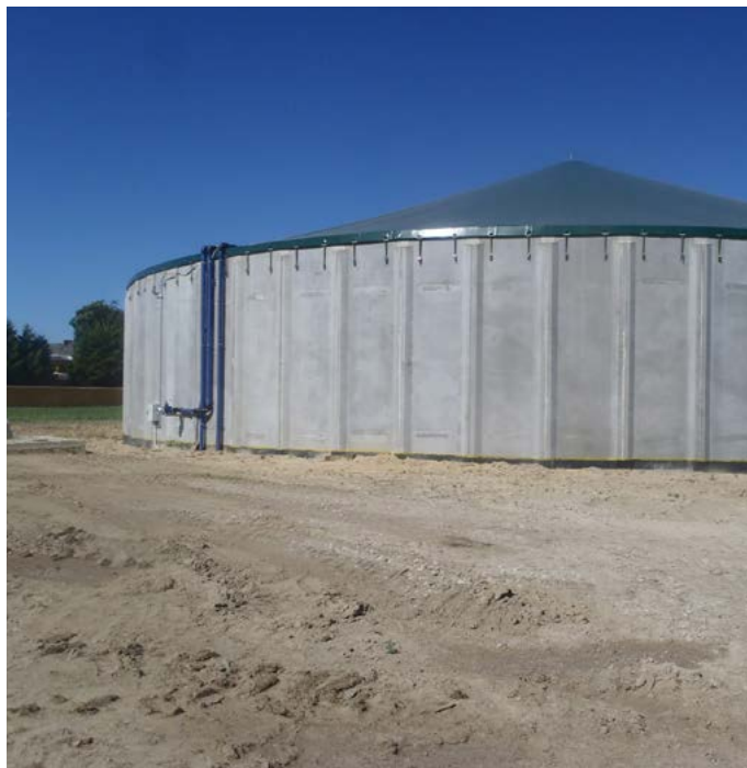
Fot. 5.4. Zbiorniki typu Corten do magazynowania gnojowicy (autor: K. Bąk)
