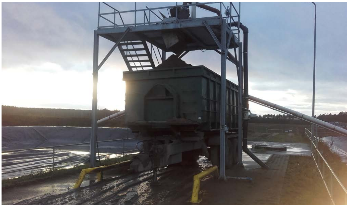
Fot. 5.6. Separator mechaniczny do gnojowicy (autor: K. Bąk)
