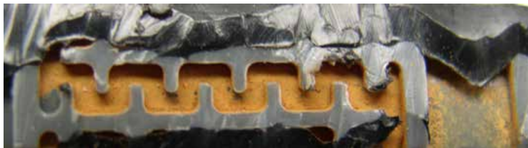
Fot. 13 Odkładające się w labiryncie kroploownika osady związków żelaza.
