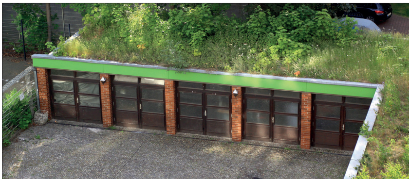
Rys.9. Semi-intensywny zielony dach pokrywający garaże w centrum dużego miasta Fot. T. Ciesielczuk.
