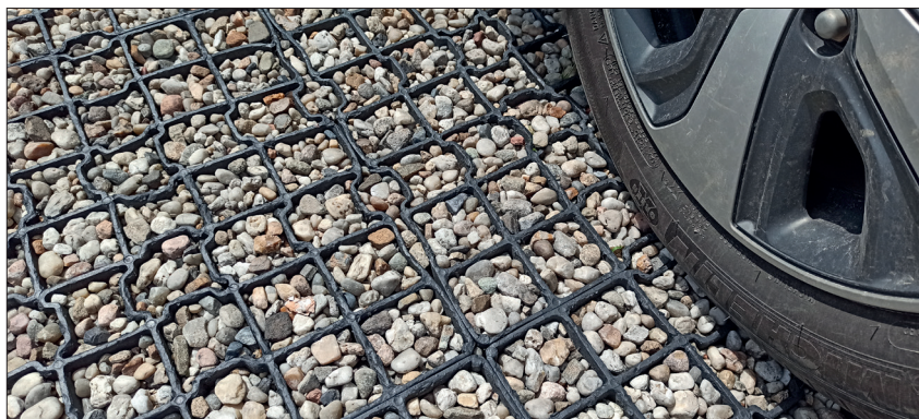
Rys.5. Geokrata wypełniona kruszywem na placu manewrowym Fot. T. Ciesielczuk
