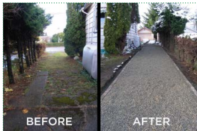
Fot. 6. Tak zamieniamy technologię nieprzepuszczalną dla wody, betonową (before) na przepuszczalną żwirową, pro-retencyjną (after)
