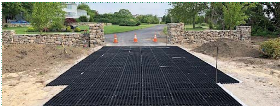
Fot. 5. Tak to wygląda przed wypełnieniem żwirem
