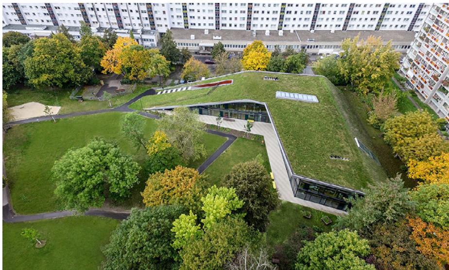
Rysunek 23. Intensywny zielony dach budynku przedszkola na osiedlu mieszkaniowym w Dreźnie płynnie łączy się z trawnikiem otaczającego parku
