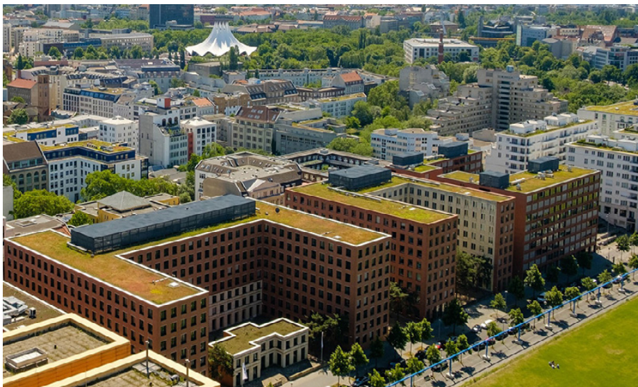
Rysunek 6. Zielone dachy w Berlinie zapobiegają powstawaniu wyspy ciepła i zatrzymują wodę opadową
