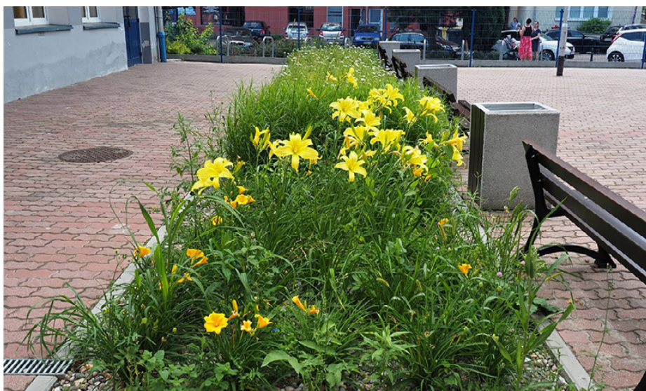
Rysunek 21. Ogrody deszczowe są jedną z opcji bioretencji wody deszczowej w miejscu jej opadu. Na zdjęciu – ogród deszczowy, zrealizowany w ramach projektu „Lubię deszcz” we Wrocławiu
