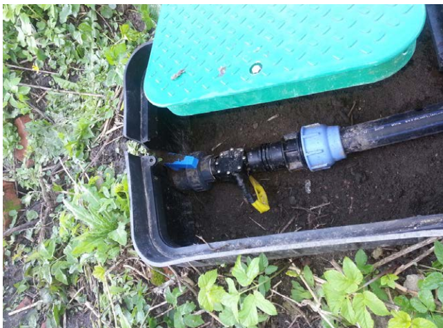
Rysunek 38. Czujnik przepływu (cyfrowy) do automatyzacji nawadniania (fot. R. Wawer)
