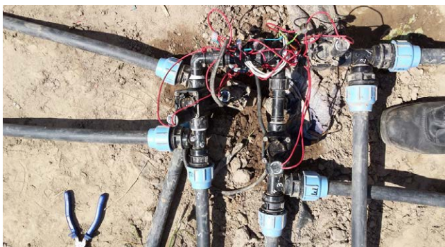
Rysunek 39. Zawory na 4 strefy nawadnianie sterowane półautomatycznie i bezprzewodowo via Internet. ENORASIS i NEPTUN (fot. R. Wawer)
