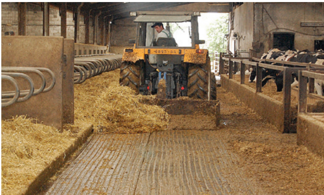
Fotografia 4.9. Szorstka, ryflowana powierzchnia podłogi (fot. J.L. Jugowar)
