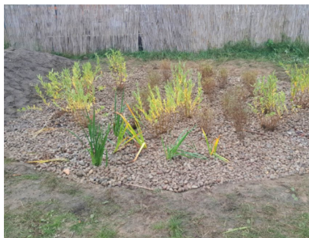
Niecka retencyjna pomagająca zagospodarować wodę gromadzącą się na placu zabaw przy przedszkolu Świetlik Montessori w Warszawie. Niecka powstała w ramach projektu Warszawa chwyta wodę realizowanego przez Fundację Sendzimira na zlecenie Zarządu Zieleni m.st. Warszawy.
