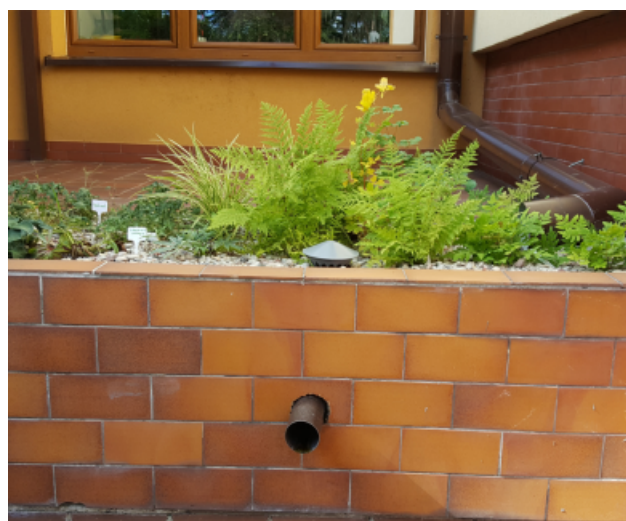
Ogród deszczowy w pojemniku zrealizowany przez Fundację Sendzimira w Zespole Szkół nr 2 w Markach w ramach projektu EkoMarki – Obywatelskie inicjatywy lokalne na rzecz środowiska sfinansowanego ze środków NFOŚiGW.
