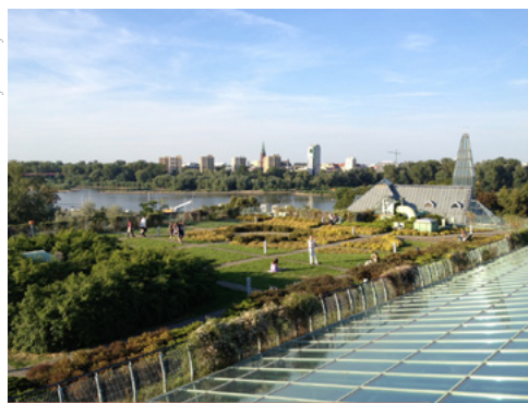
Rysunek 1. Zielony dach na budynku Biblioteki Uniwersytetu Warszawskiego
