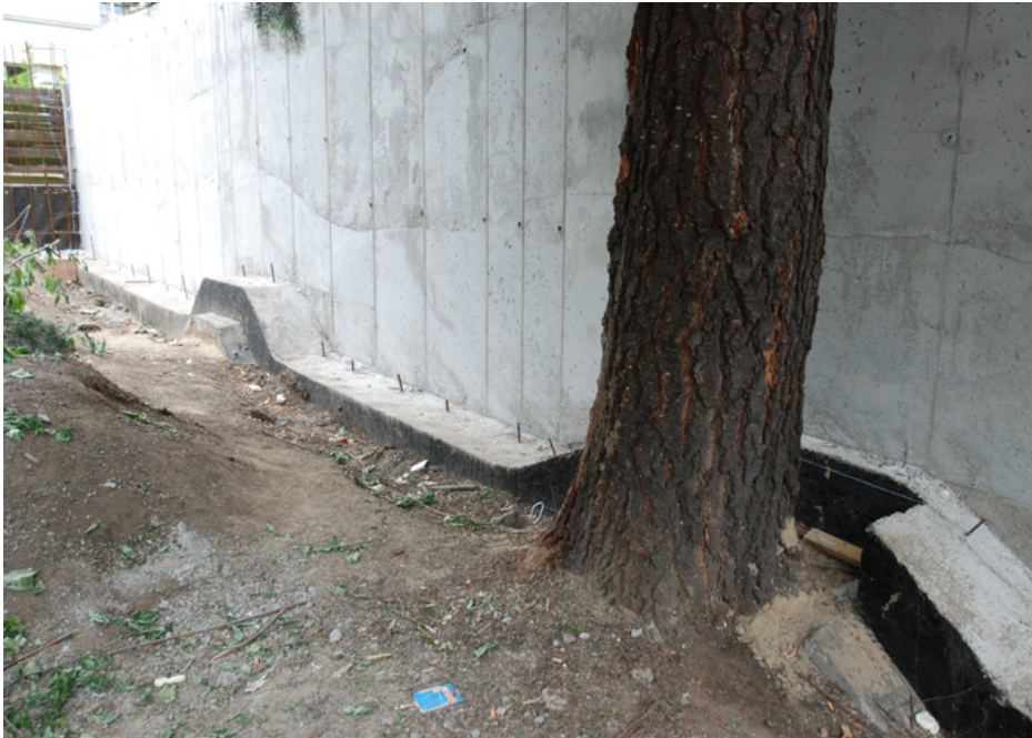
Rysunek 6. Specjalne prowadzenie ogrodzeń na granicy działki, nad systemem korzeniowym, pełne z rampą i wsparte punktowo
