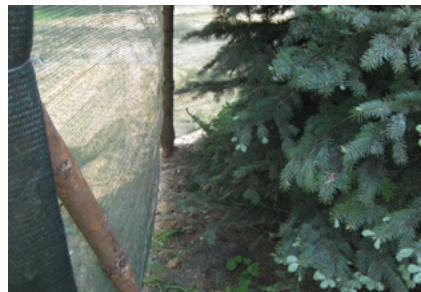
Rysunek 9. Ogrodzenie ochronne drzew na terenie inwestycji
