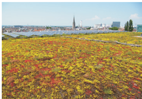
Rysunek 2. Zielony dach na Centrum Wystawienniczym w Bazylei (Messe Basel), około 16 000 m 2 jest porośniętych mchem, rozchodnikami i roślinami zielnymi. Roślinność obniża temperaturę powietrza nad dachem, zwiększając wydajność paneli słonecznych (w tle). Drewniane elementy zostały dodane w celu zwiększenia bioróżnorodności oraz jako dekoracja
