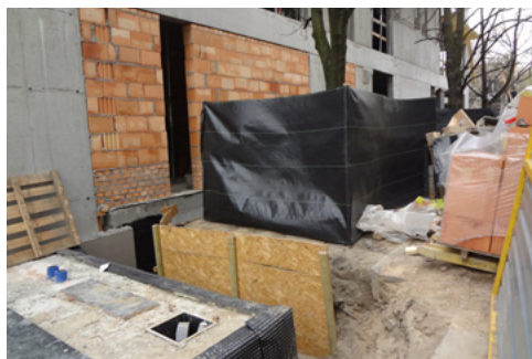
Rysunek 7. Technologia wykonania ściany garażu wymagała odsunięcia tymczasowej szczelnej ścianki wykopu o 90 cm w stronę drzewa, co nie zostało uwzględnione w projekcie. To typowy problem, którego należy unikać
