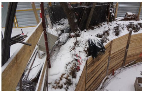
Rysunek 6. Zasłona korzeniowa i ogrodzenie ochronne drzew
