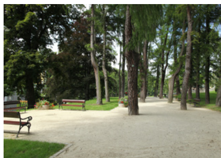
Rysunek 7. Przepuszczalna nawierzchnia HanseGrand ułożona w sąsiedztwie drzew, jako rozwiązanie mniej inwazyjne od standardowych nawierzchni
