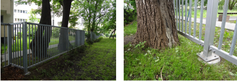
Rysunek 15. Zmiana biegu ogrodzenia oraz punktowe jego wsparcie w celu ochrony korzeni drzew
