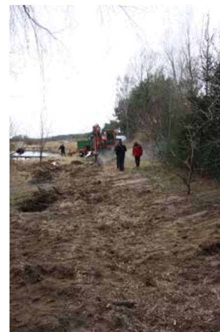
Prace ziemne w trakcie konstruowania ściany denitryfikacyjnej
