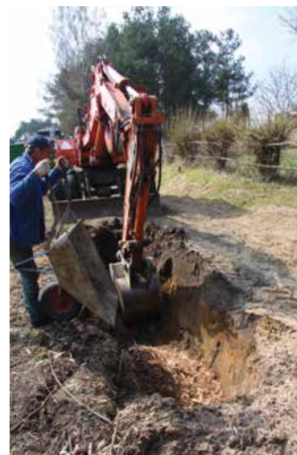
Prace ziemne w trakcie konstruowania ściany denitryfikacyjnej
