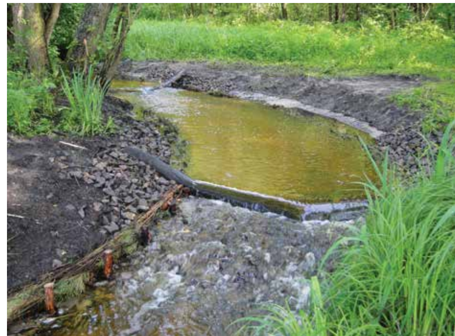
Skonstruowane progi sedymentacyjne na Dopływie z Goleszy Dużych powyżej cofki
