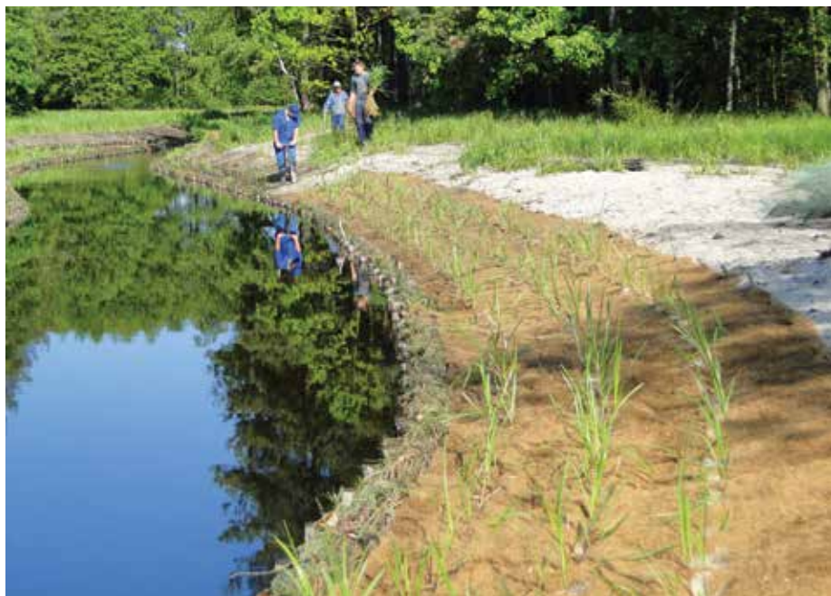
Nasadzenia w obszarze skarp umocnionych matą kokosową (wiosna 2013)
