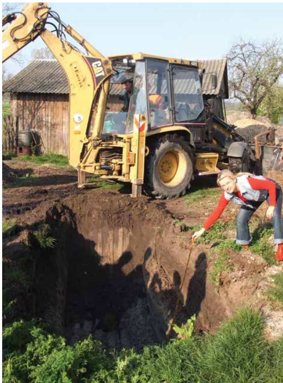
Etapy budowy bariery denitryfikacyjnego do rekultywacji zanieczyszczeń punktowych (obornik z tuczarni trzody chlewnej w Uniejowie)
