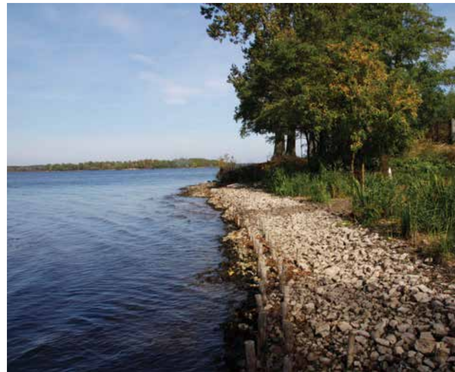
Odtworzenie skarpy brzegu i umocnienie jej przez płotki faszynowe wypełnione kamieniem wapienno-dolomitowym przy różnym poziomie piętrzenia zbiornika
