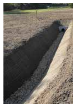
Wylot oraz rów infiltracyjny (fotografie z lewej strony) oraz niecka i przegroda gabionowa wyłożone kamieniem wapienno-dolomitowym, w tle strefa biofiltracyjna (fot. prawa)
