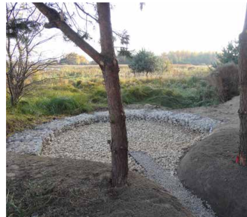
Wylot oraz rów infiltracyjny (fotografie z lewej strony) oraz niecka i przegroda gabionowa wyłożone kamieniem wapienno-dolomitowym, w tle strefa biofiltracyjna (fot. prawa)
