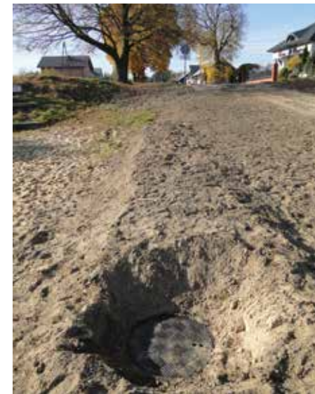
Kratka odpływowa wraz z zainstalowaną w dnie studzienką sedymentacyjną (fot. lewa), odcinek podziemny systemu ze studzienką sedymentacyjno-filtracyjną (fot. prawa)
