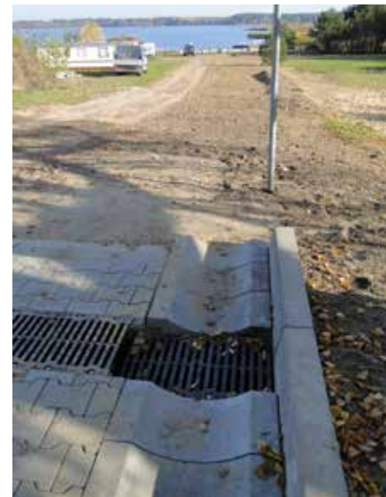
Kratka odpływowa wraz z zainstalowaną w dnie studzienką sedymentacyjną (fot. lewa), odcinek podziemny systemu ze studzienką sedymentacyjno-filtracyjną (fot. prawa)
