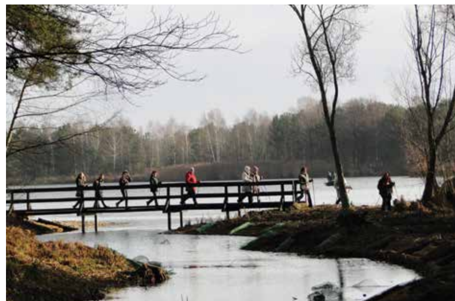
Ukształtowane soczewki żwirowo-piaskowe w celu zwiększenia procesu mineralizacji (fot. górna). Dodatkowo w celu usprawnienia komunikacji rekreacyjnej wzdłuż zbiornika zainstalowano nad ciekami kładkę dla pieszych (fot. dolna) (jesień 2012)
