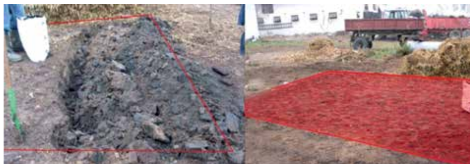
Etapy budowy poziomej warstwy denitryfikacyjnej pod składowiskiem obornika we wsi Jerwonice, na czerwono zaznaczono powierzchnię warstwy
