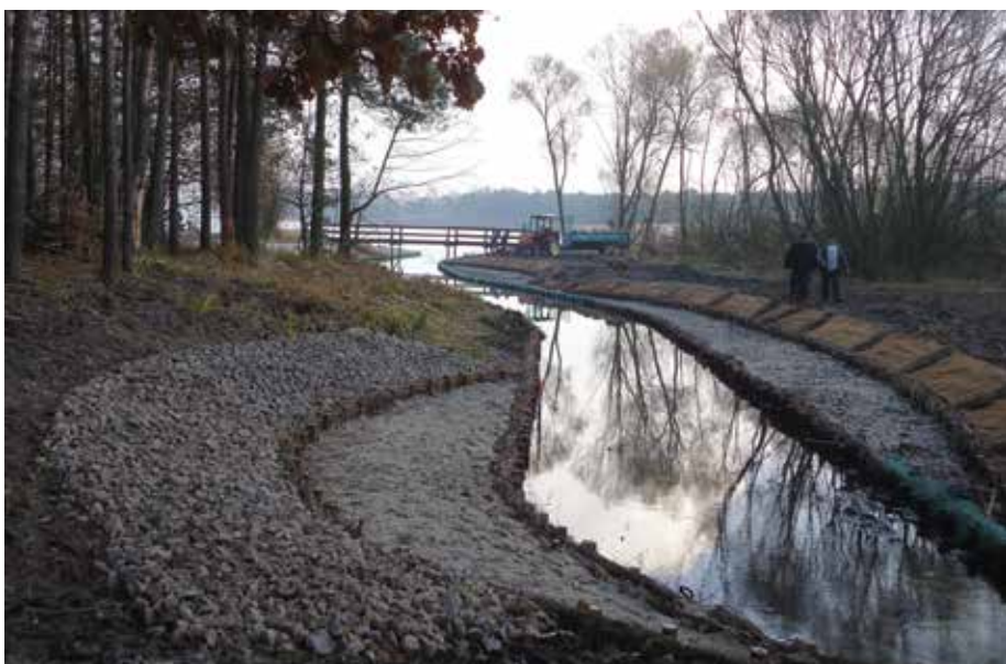
Prace ziemne w trakcie odtwarzania skarp oraz kinety cieków
