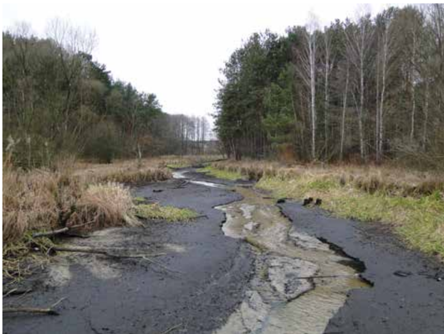
Namuły w dnie cieków widoczne przy niskiej rzędnej piętrzenia zbiornika, stan przed rozpoczęciem prac
