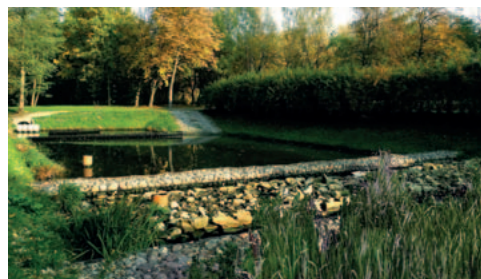
Rysunek 14. Sekwencyjny system sedimentacyjno-biofiltracyjny — schemat i jego pilotażowe wdrożenie na rzece Sokółówce w Łodzi
