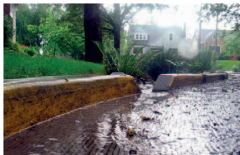
Rysunek 3. Obniżenie krawężnika pozwala na odpływ wody z ulic i chodników. Na zdjęciu — woda odpływająca z ulicy NE Siskiyou w Portland, Oregon, Stany Zjednoczone
