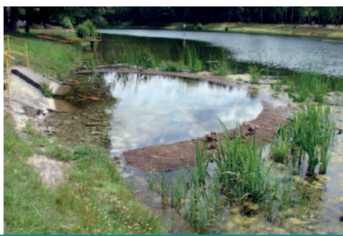
Rysunek 15. Strefa buforowa z barierą biogeochemiczną do podczyszczania wód odprowadzanych bezpośrednio do zbiornika wodnego — schemat i przykład pilotażowego zastosowania na stawach w Arturówku w Łodzi
