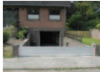
*W starych i nowych budynkach należy unikać wtargnięcia wody powodziowej do domu przez okna i drzwi. Dlatego należy przygotować zapory wodne, bardzo dokładnie uszczelniające otwory w budynku. Klasycznym środkiem są worki z piaskiem, ale można przygotować też ruchome barierki z aluminium lub drewna i folii, którymi można będzie zakryć okna i drzwi w sytuacji zagrożenia. Możliwa jest również kombinacja obu rodzajów środków ochronnych: zapór z worków z piaskiem oraz barierek aluminiowych. ■*
