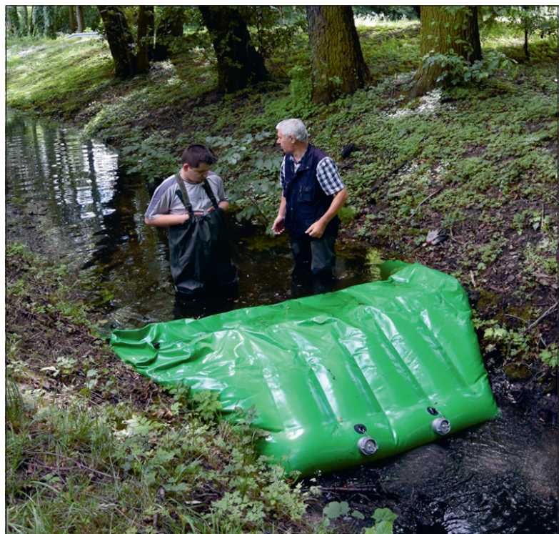
Rysunek 7. Przenośny próg piętrzący samoczynnie napełniający się wodą płynącą w rowie (Zakład Inżynierii i Gospodarki Wodnej ITP – fot. K. Krężalek)
