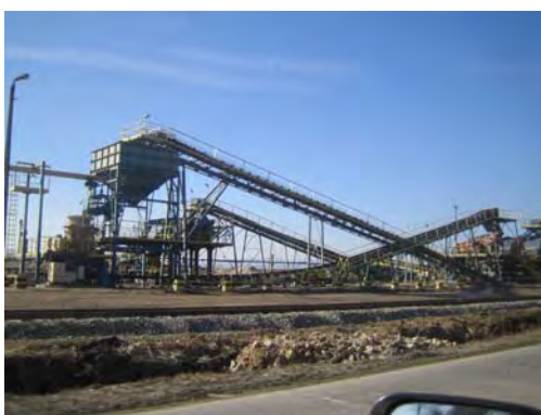
Rys. 3. Zbiornik Topola. Miejsce przeładunku kruszywa (fot. M. Sieinski)
