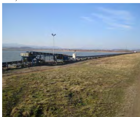
Rys. 4. Zbiornik Topola. Taśmociąg transportowy biegnący po lewej zaporce bocznej (fot. M. Sieinski)
