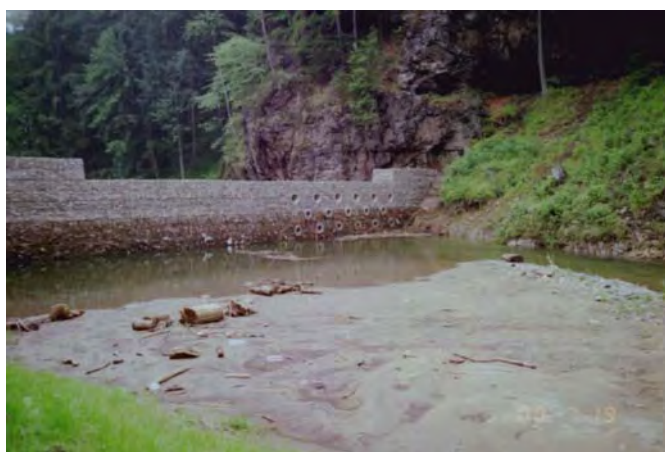
Rys. 15. Zapora przeciwrumowiskowa Wilczka – Międzygórze, widok od strony wody górnej (fot. J. Winter)
