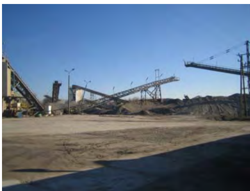
Rys. 1. Zbiornik Nysa. Taśmociągi w części składowania urobku (fot. M. Sieinski)
