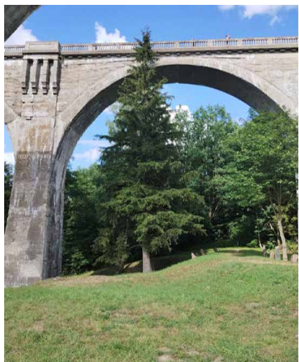
Fot. 19. Pokrój świerka pospolitego rosnącego przy wiaduktach kolejowych Stańczyki (woj. warmińsko-mazurskie).
